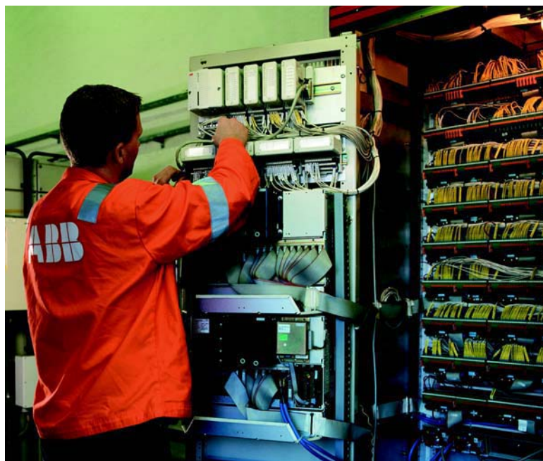
图 6. 模块配备有诊断 LED，并可带电更换、简化维护。
